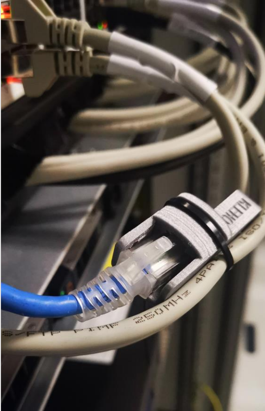
Instalación paralela a cable utilizando brida.
